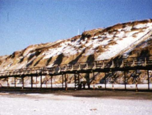
Am Dünenfuß aufgetretene Erosionen sind als Folge resonanter **Beckenschwingungen** bei hohem Wasserstand anzusehen. Dabei spricht die Steilheit der Böschungsneigung für den Effekt **massiv positiver partieller Reflexion**.
